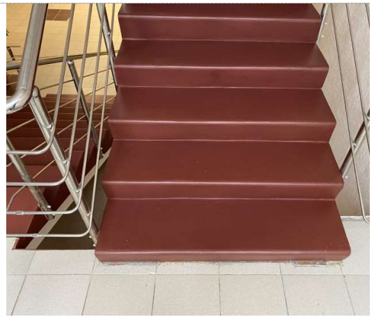
Фото №20 – Пути движения внутри здания (лестницы)
