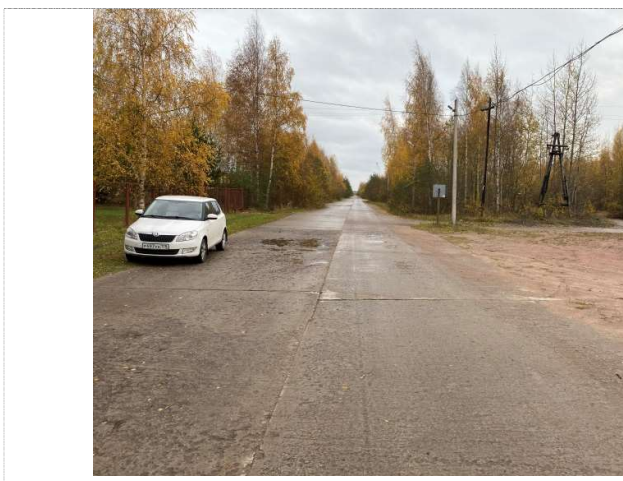
Фото №1 – Подходы к объекту.
