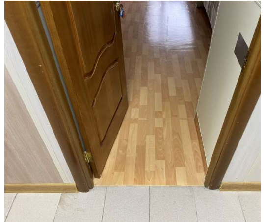
Фото №22 – Пути движения внутри здания (двери)
