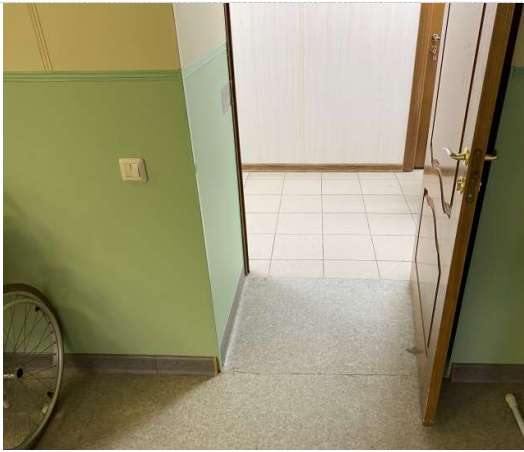
Фото №21– Пути движения внутри здания (двери)
