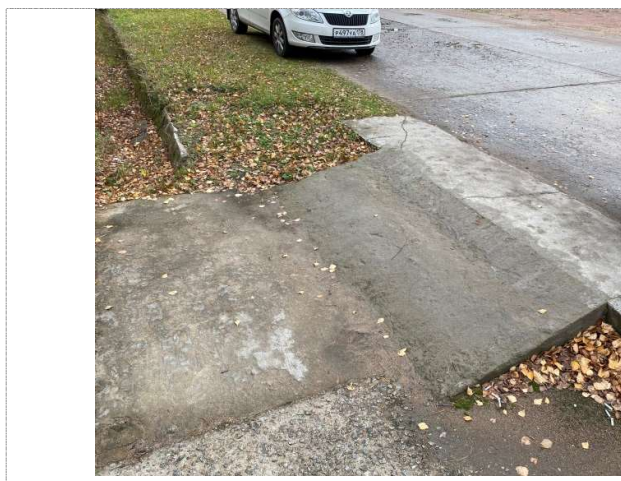
Фото №2 – Подходы к объекту.
